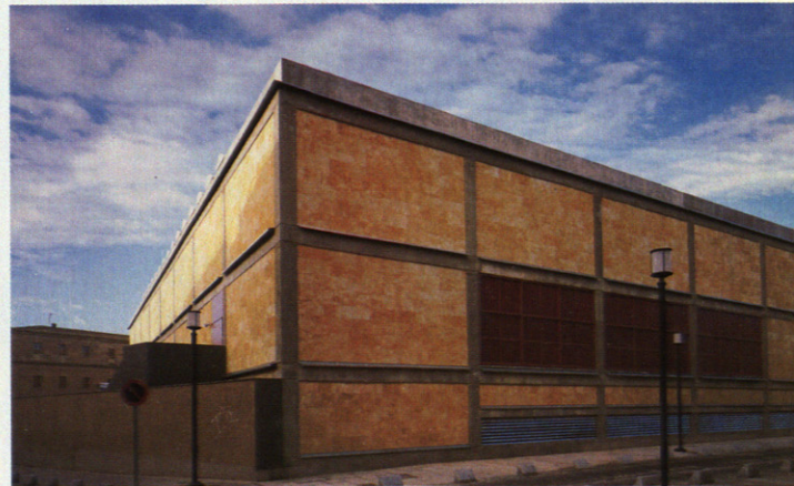
72 · VISTA DESDE LA CONFLUENCIA DE LAS CALLES DEL TRILINGÜE Y DE LAS MAZAS
